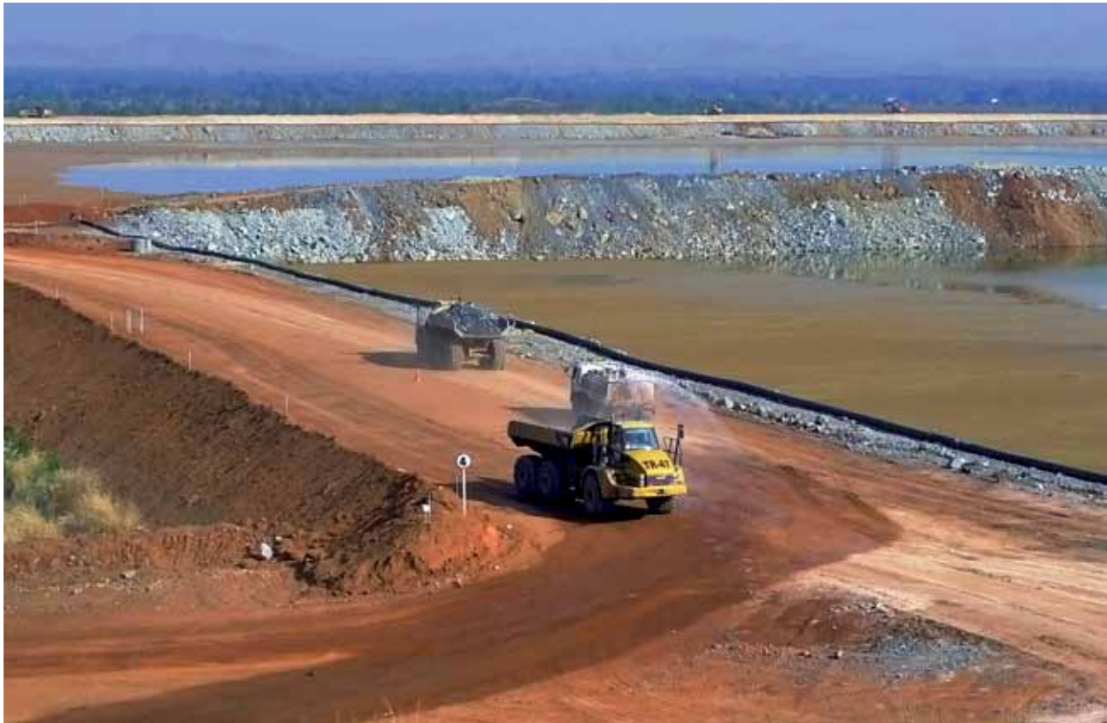
รถบรรทุกน้ำกำลังฉีดน้ำบนถนนรอบบ่อน้ำทิ้งของบริษัท อัคราฯ ป้องกันฝุ่นฟุ้งกระจาย – วัชรินทร์ สุวสนนุญ A water truck sprays its load on the trail next to a wastewater retention pond in Akara Mining's gold mine to keep dust down. – Chatphat Suwanyuha
