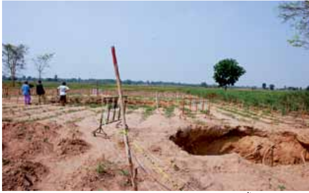
หลุมยุบ ใน อ.พรหมทองคำ จ.นครราชสีมา ผนวกจากการสูบน้ำเกลือใต้ดินขึ้นมาผลิตเกลือ - โสธิดา นูรัต A sink hole in Phra Thongkham district of Nakhon Ratchasima province was caused by salt making through pumping up saline water underground. - Sothida Nurat
